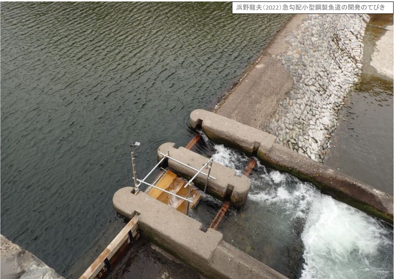
応用事例: 現魚道にはめ込んで落差・流速を緩和するための魚道。大成功！
