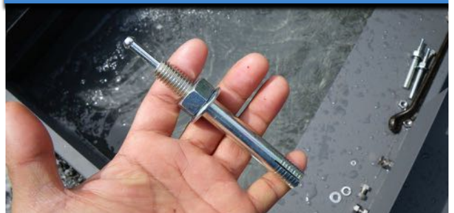
③オールアンカーを打ち込み、最後に魚道を固定する。治具を作っておくと、水がある状態でも打ち込みやすい
