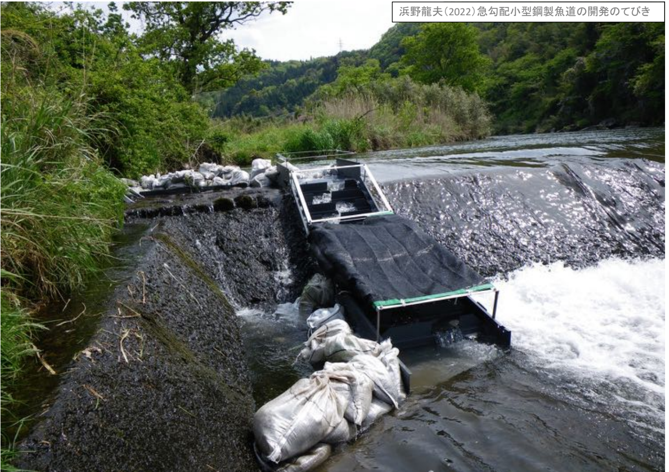
事例:現地での鋼製魚道仮設例(入口に魚を誘導する工夫が大事) 遡上しました!
