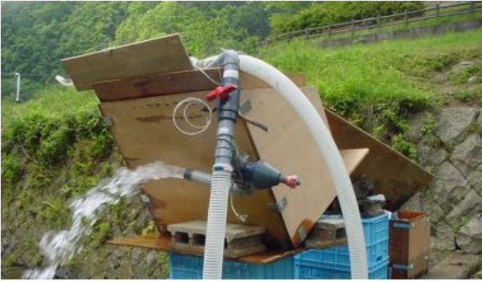
上流端のプールへの配水
