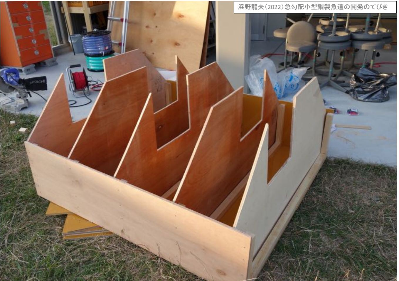
応用事例: 現魚道にはめ込んで落差・流速を緩和するための魚道
