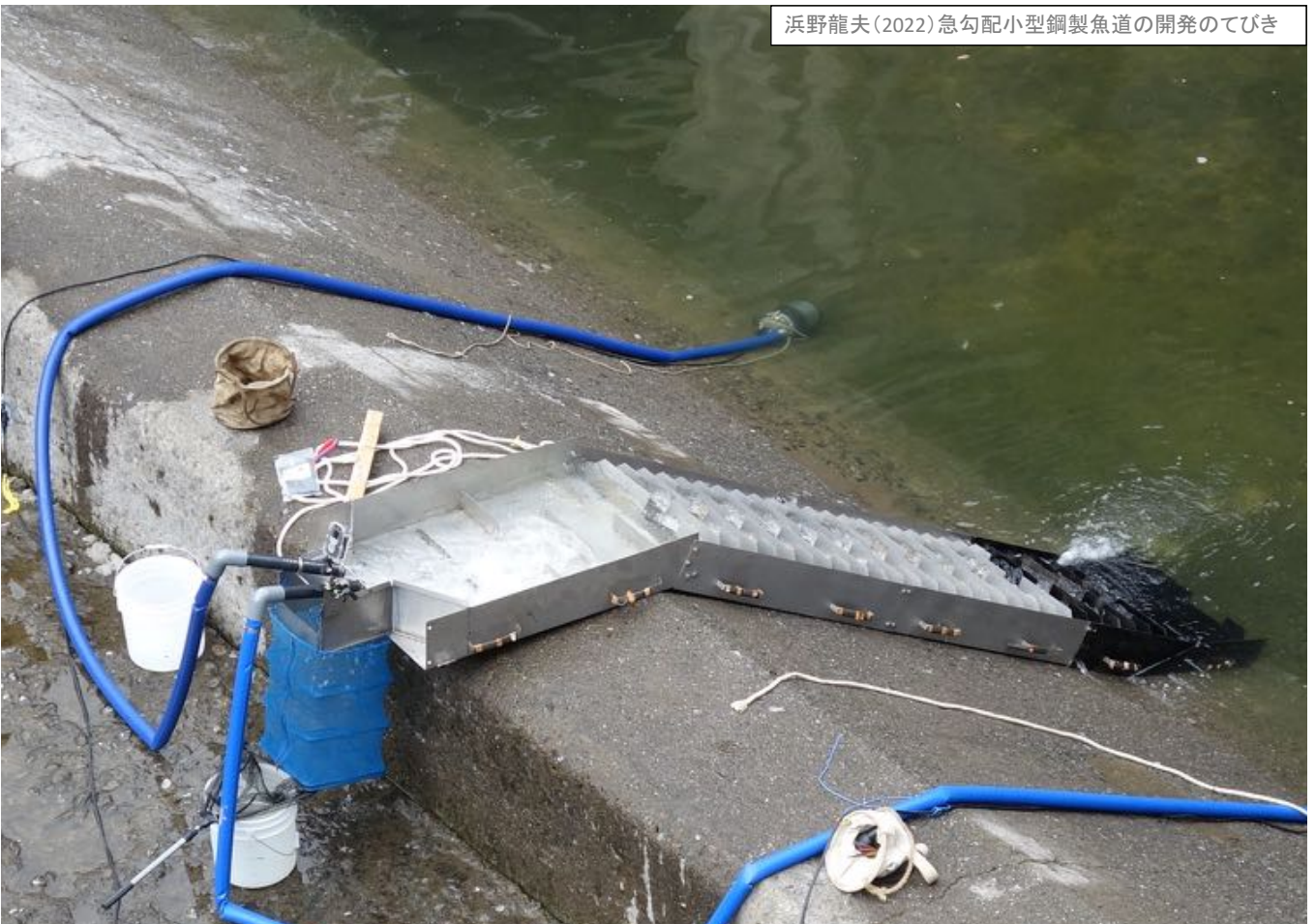
事例:現地での鋼製魚道仮設例(入口に魚を誘導する工夫セズ) 少し遡上しました!
